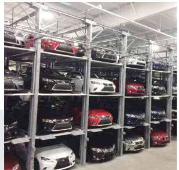
O sistema HP3130 permite parquear em 3 níveis e o HP3230 em 4 níveis, permitindo um elevadíssimo nível de aproveitamento do espaço de estacionamento.
